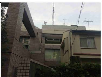
南東側隣地：住宅が迫っており、改修時や運営上、視線や騒音への配慮が必要である。
