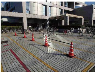
駐輪場：バスが停車するスペースと重複している部分がある。
