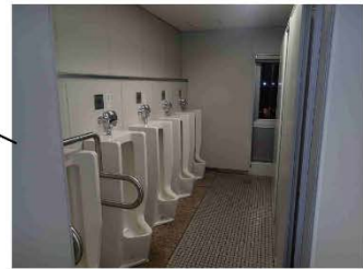
トイレ：2階は多目的トイレがない。また、各階のトイレは湿式であり、衛生面を考慮すると乾式とすることも考えられる。
