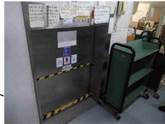
小荷物専用昇降機：地下1階のレファレンスカウンターとを結んでいる。
