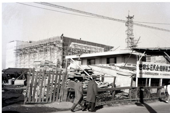
建設中の区民会館1958（昭和33）年
